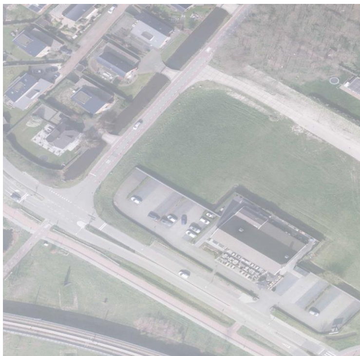
Bestaande situatie Hofwegenstraat
